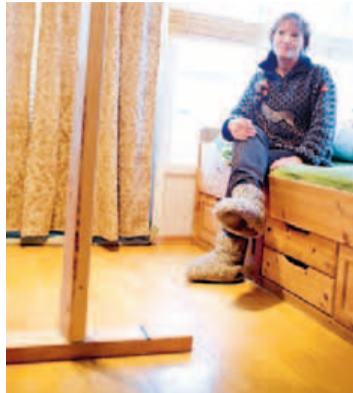
STØTTE. I stuen er det satt opp en stolpe som skal hindre påbygget å bli mer skjevt
